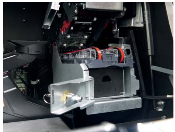
Figura 4.4.f Acceso interior validador - 2
